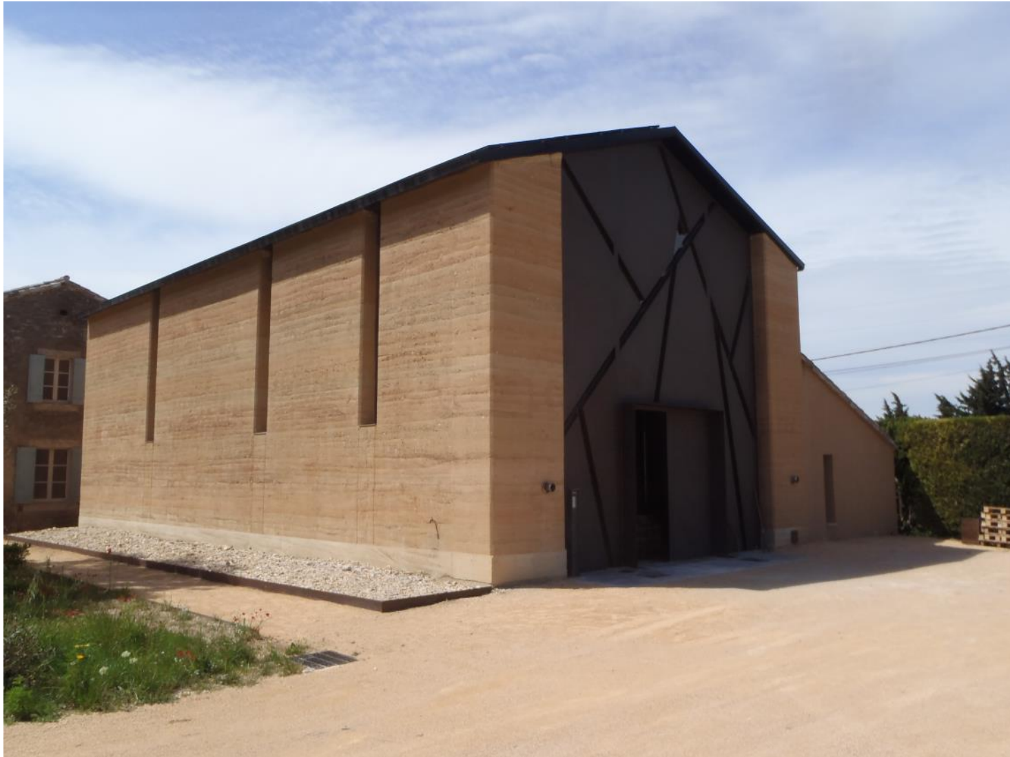
Chais viticole du Domaine de Trévallon, St-Etienne-du-Grès, 2013. Mur de 16 m de long et 7 m de haut + trumeaux.
