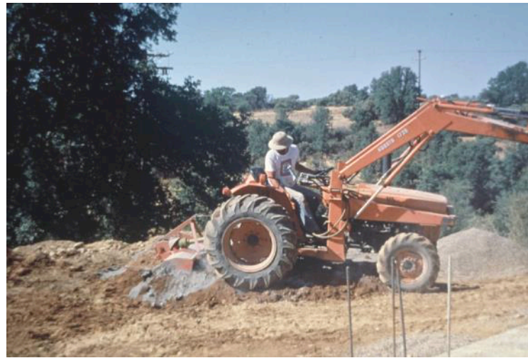
Préparation de la terre : stabilisation à 5%, humidification, mélange
