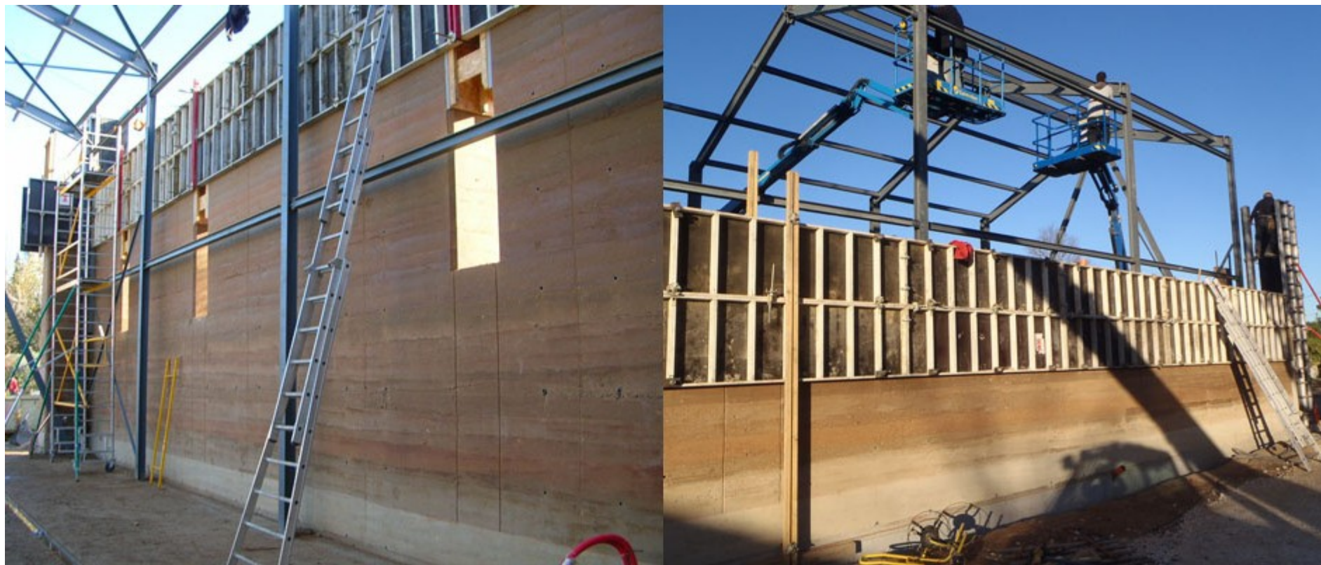
Chais viticole du Domaine de Trévallon, St-Etienne-du-Grès, 2012. Mur de 16 m de long et 7 m de haut + trumeaux.
