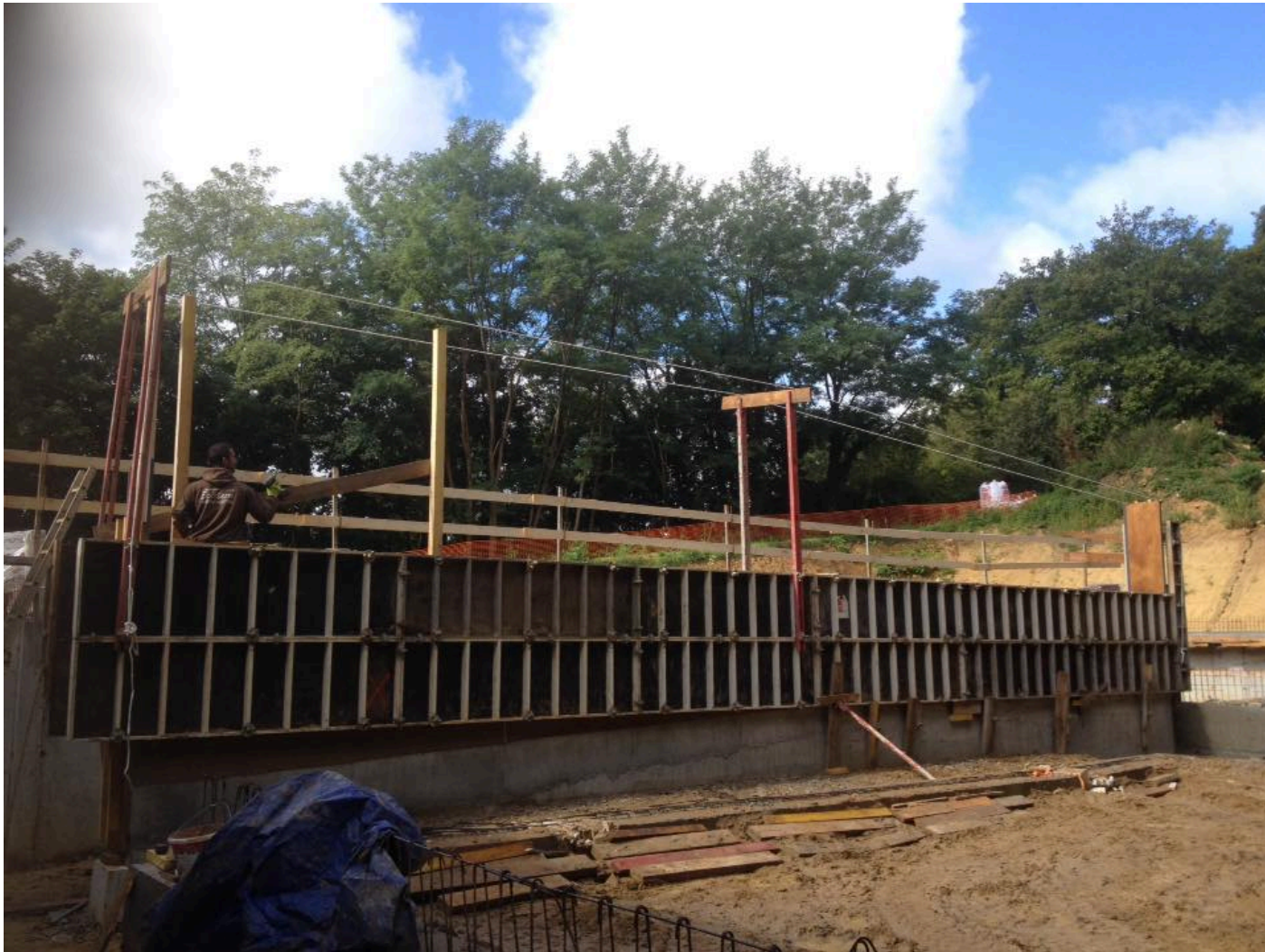
Chantier en cours : 140 m 2 de murs en pisé pour la salle culturelle de Chateaufort en Yvelines. Marché public. Septembre - octobre 2017
