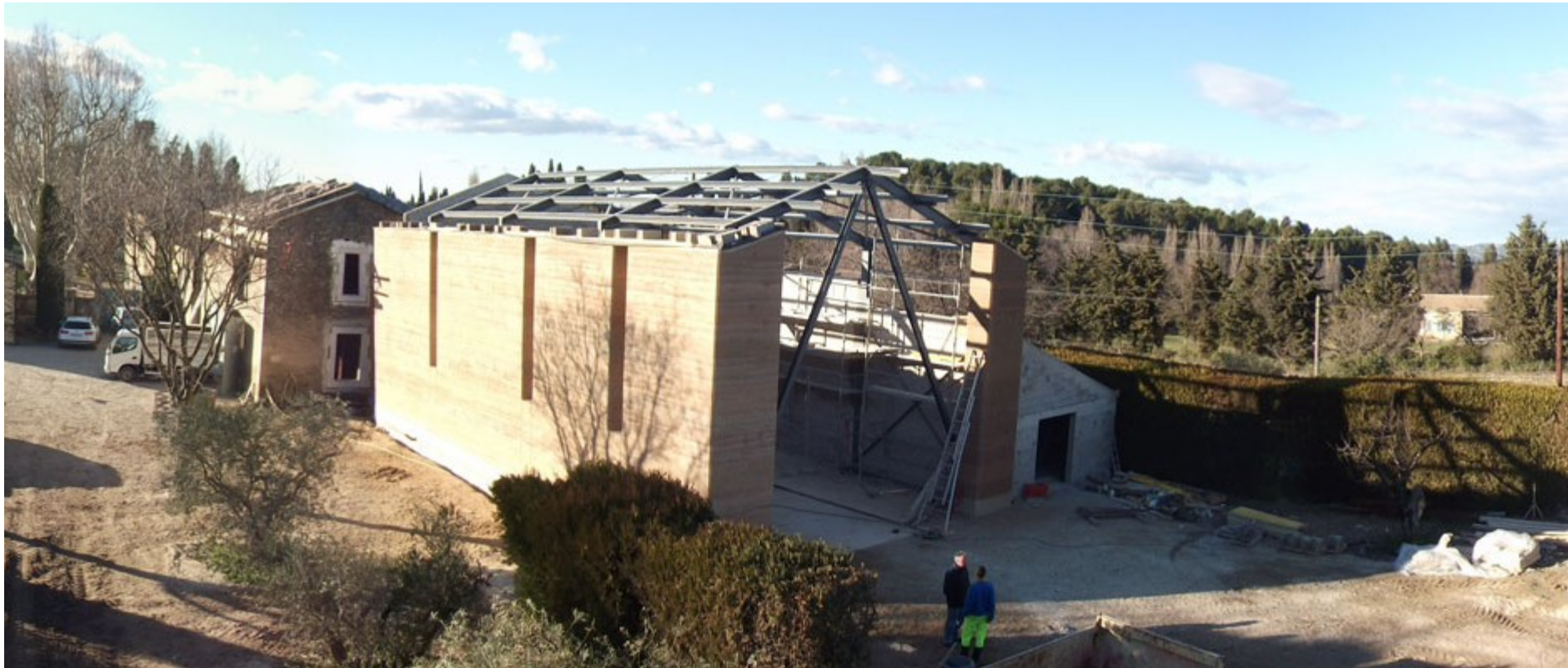
Chais viticole du Domaine de Trévallon, St-Etienne-du-Grès, 2013. Mur de 16 m de long et 7 m de haut + trumeaux.
