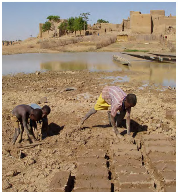
Photo de gauche : Fabrication des briques traditionnelles cylindriques « djenné ferey ».
